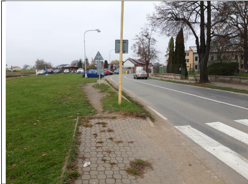
Obr. 12 Chybějící chodník mezi přechodem pro chodce a parkovištěm na příjezdu ke hřišti. Foto: Z. Sperat
