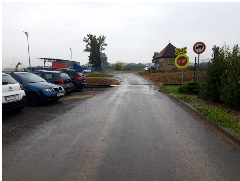
Obr. 11 Nechráněný železniční přejezd bez závor a zvukového a světelného zabezpečení. Foto: Z. Sperat
